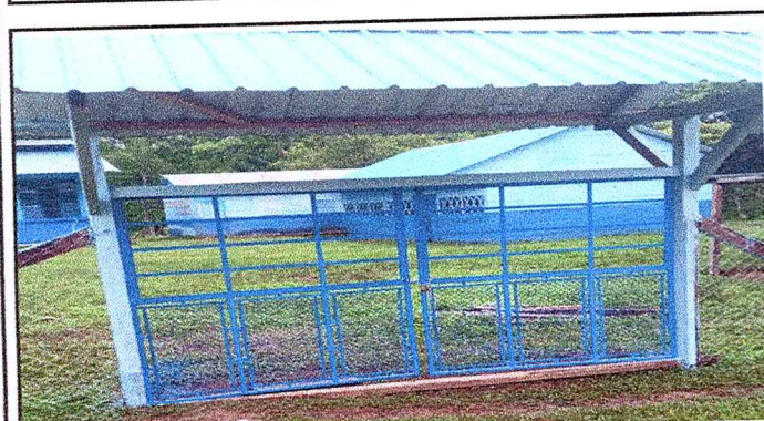
Foto 3: Mantenimiento de porton.
