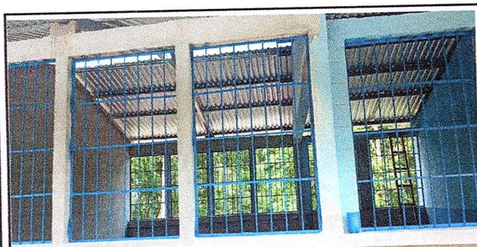
Foto 5: Cambio de ventanas.
