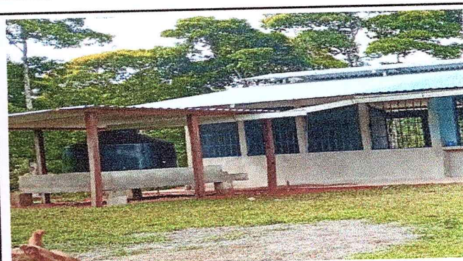
Foto 4: Nuevo lavamanos múltiple.
